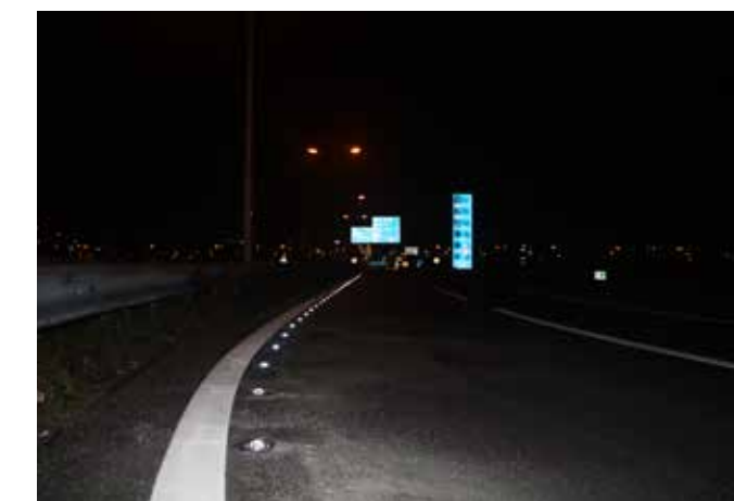
Afslag Schiphol, toepassing van LUX glasbolreflectoren voor maximale verkeersveiligheid in scherpe bochten.
